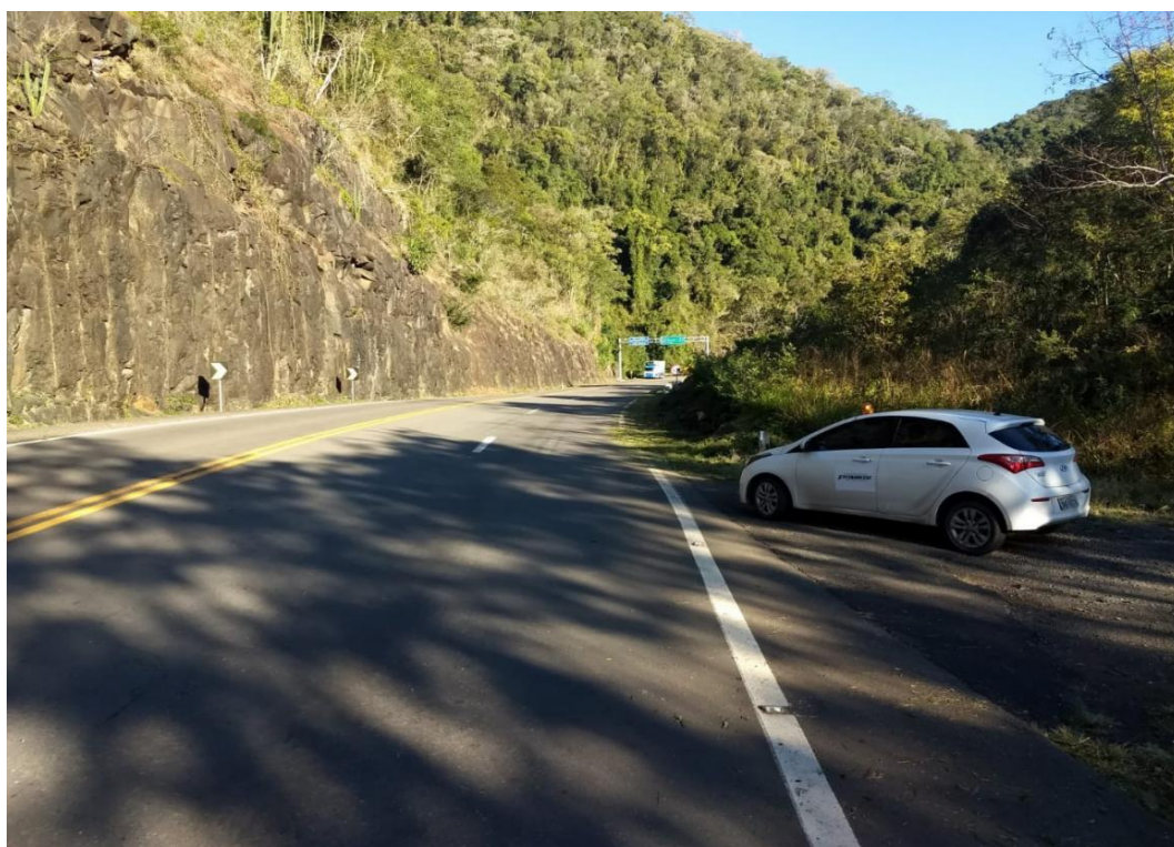
Foto 7 - Saída de campo BR-470/SC Fonte: autores (2021).
