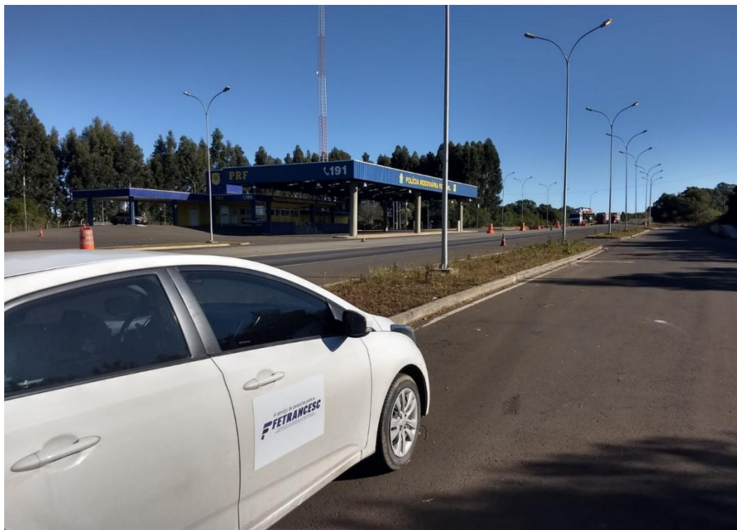
Foto 2 - Saída de campo BR-470/SC Fonte: autores (2021).
