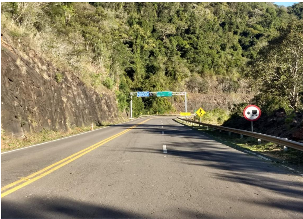
Foto 8 - Saída de campo BR-470/SC Fonte: autores (2021).
