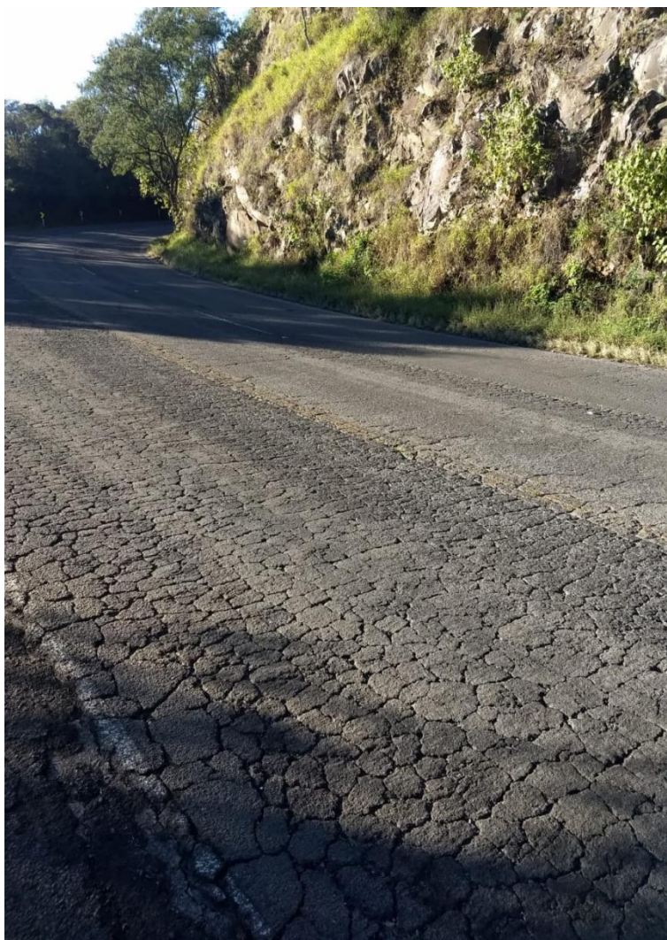
Foto 10 - Saída de campo BR-470/SC Fonte: autores (2021).
