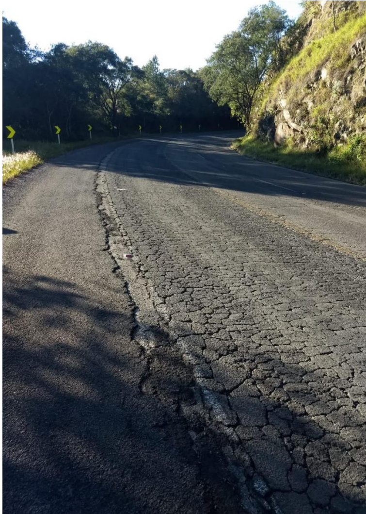
Foto 11 - Saída de campo BR-470/SC Fonte: autores (2021).
