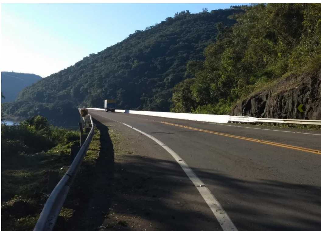
Foto 9 - Saída de campo BR-470/SC Fonte: autores (2021).
