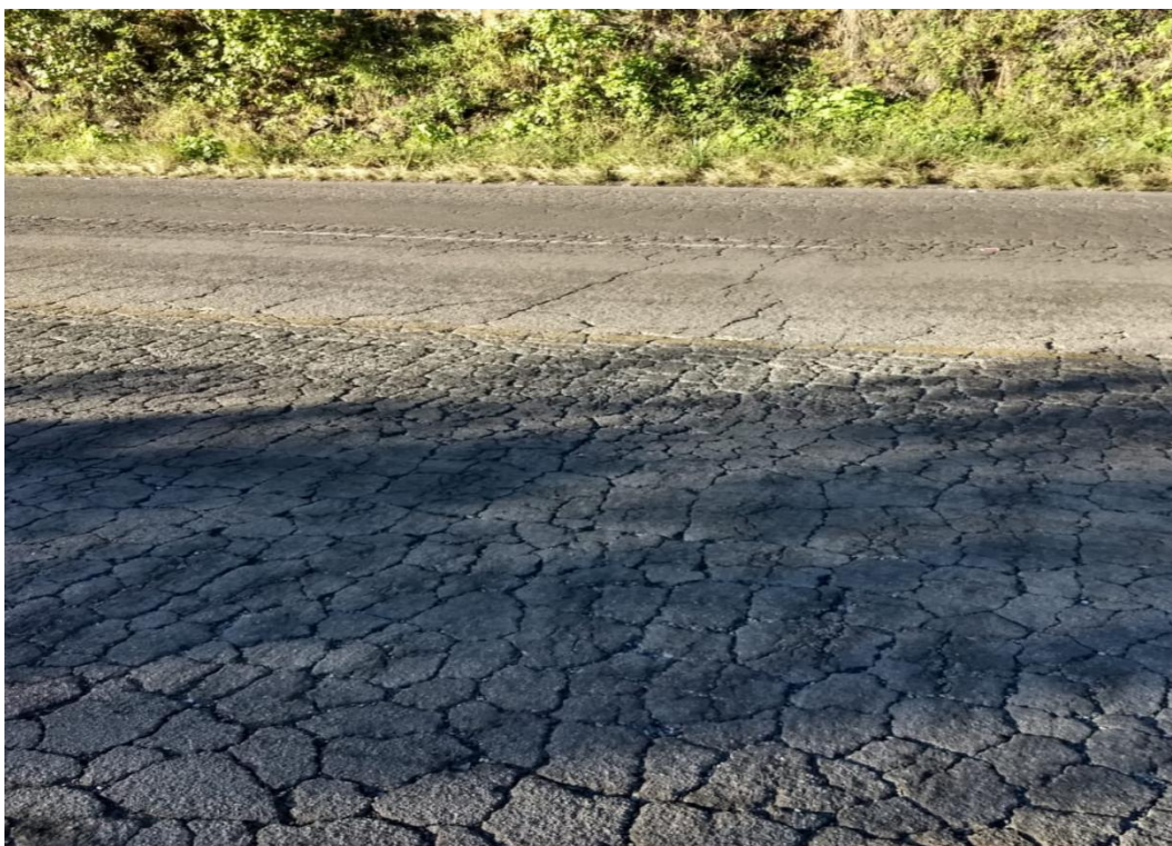
Foto 12 - Saída de campo BR-470/SC Fonte: autores (2021).
