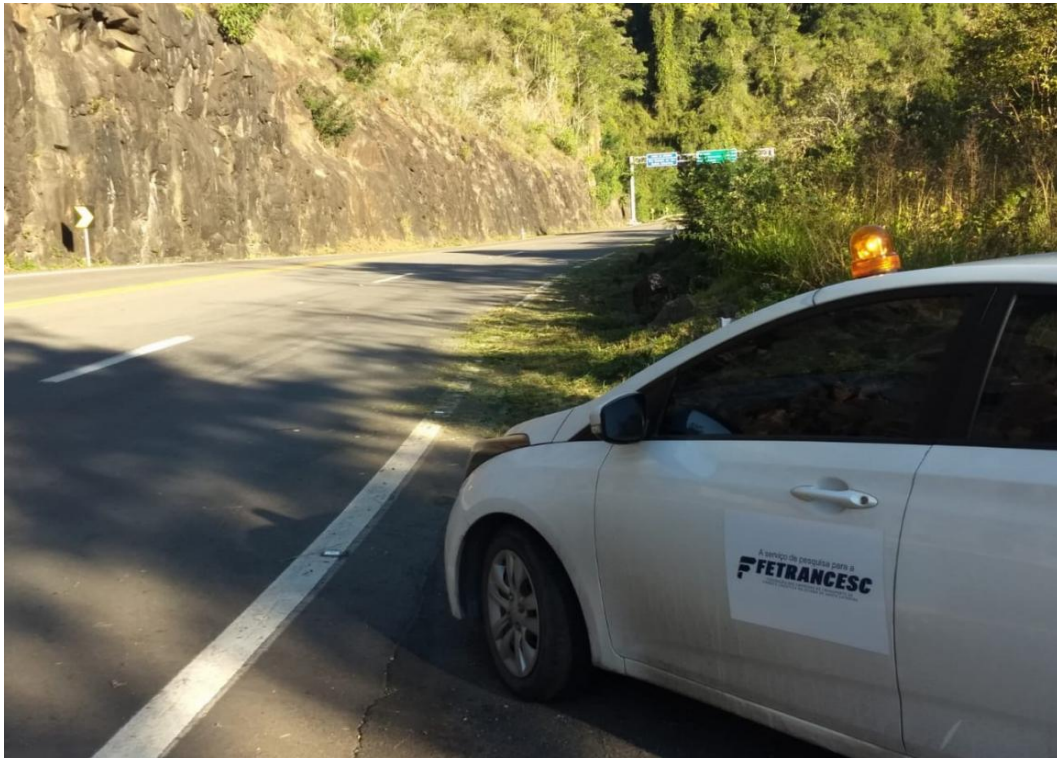
Foto 4 - Saída de campo BR-470/SC Fonte: autores (2021).
